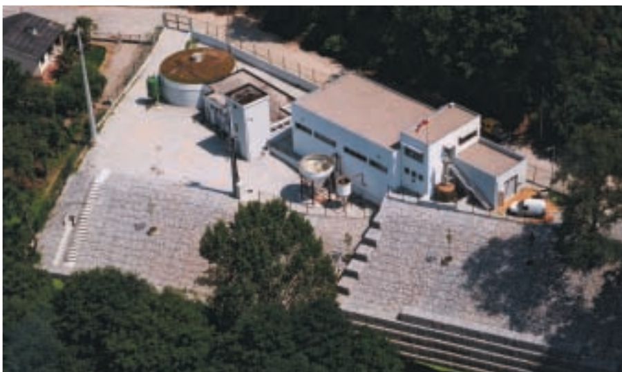
Vista aérea da ETA do Ferro
