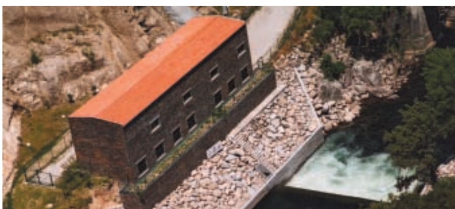
Vista aérea do Açude no rio Paiva e da Estação Elevatória da captação da Bateira
