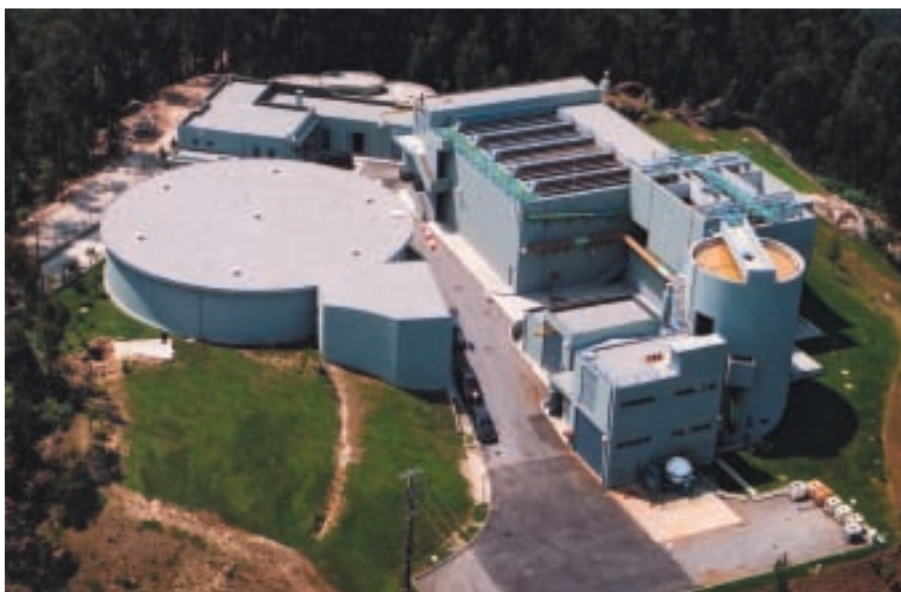
Vista aérea da ETA de Castelo de Paiva
